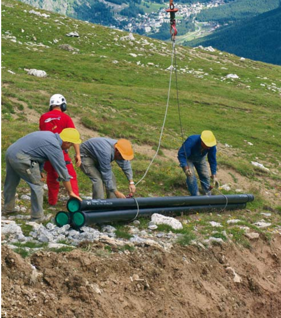
1 Transport des tuyaux par hélicoptère sur les terrains difficiles d'accès 2 Marguns: départ de l'hélicoptère après le déchargement de tuyaux vonRoll ductipur en fonte ductile
