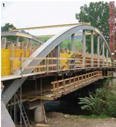
1 Pont du Rietwis en construction 2 Le tuyau vonRollecopur en fonte ductile avec verrouillage intérieur vonRollhydrotight est préparé à l'assemblage
