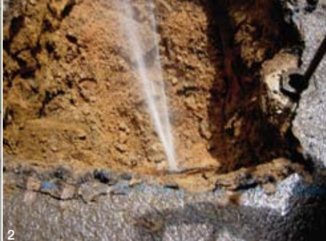
1 Définition des points de mesure Ortomat® 2 Fuite n° 8 3 Délimitation de la fuite
